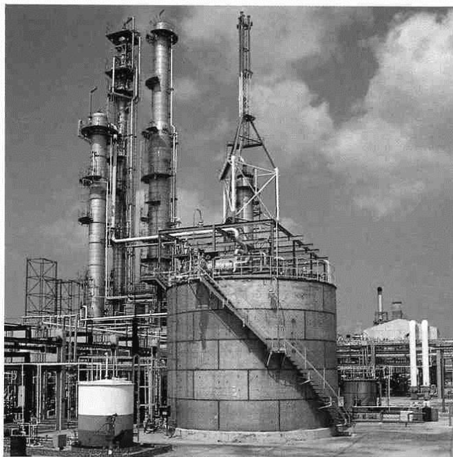
Vista general de la planta de acrílo-nitrilo en el complejo petroquímico Morelos, en Veracruz; abajo, vista general de las unidades 1 y 2, con capacidad de 350 MW cada una, de la central termoeléctrica Petacalco, en Petacalco, Gro.
