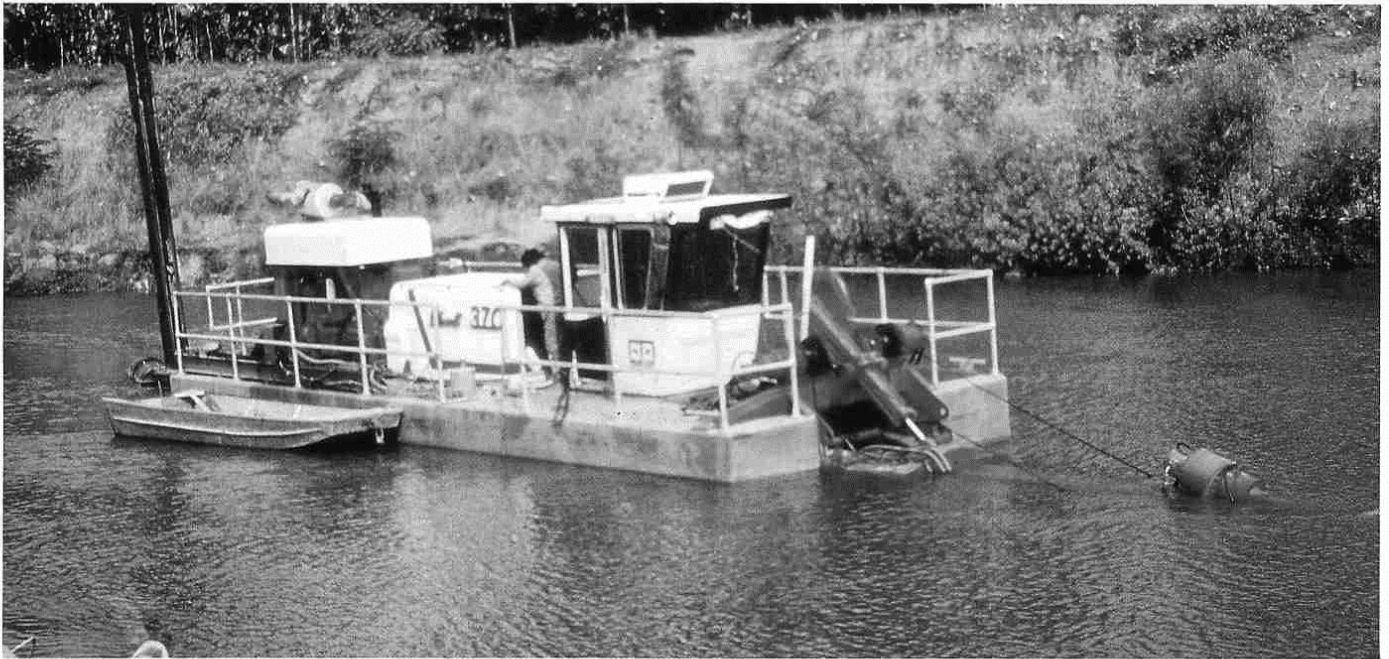
Trabajos de dragado en el desarenador Saldaña, en Colombia; abajo, remoción de arena por medio de dragas en ese mismo desarenador.
