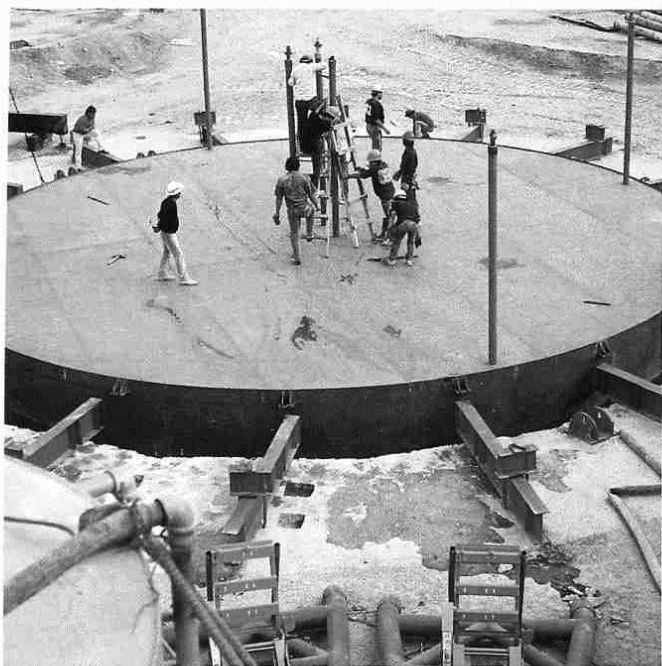
Vista general del tanque flotador posicionado y listo para iniciar los colados de la lumbrera 3 del interceptor oriente-orientado con el método de flotación; abajo, vista del viaducto vehicular y para tuberías del muelle petrolero de Salina Cruz, Oax.
