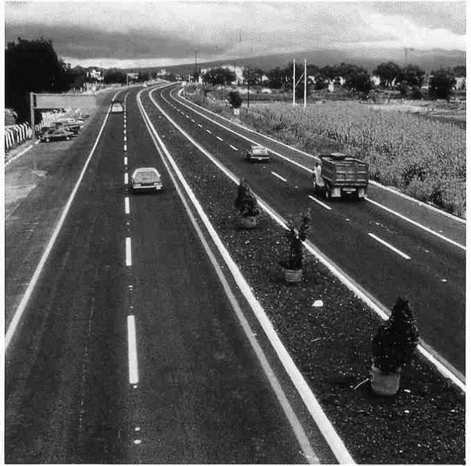
Autopista San Martín Texmelucan—El Molinito, a cuatro carriles con camellón central; abajo, libramiento poniente de Tampico.
