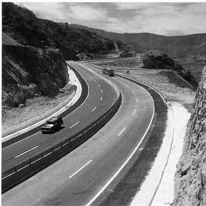
Panorámica de un tramo en operación de la autopista Plan de Barrancas; abajo, descenso del escudo cortador de frente presurizable de 4 m de diámetro.
