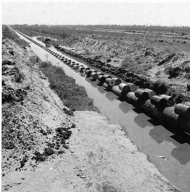
Oleoducto Nuevo Teapa—Medias Aguas en Veracruz; abajo, trabajos de hincado de pilotes para la construcción del muelle en Topolobampo, en Los Mochis, Sinaloa.
