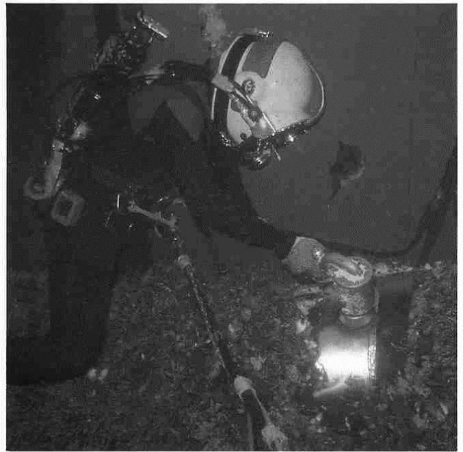
Técnico en buceo retirando la flora y fauna marinas en un ducto ascendente de una plataforma para realizar la inspección de un cordón de soldadura con partículas magnéticas; abajo, ilustración de la estación Coyuya de la línea 8 del Metro.
