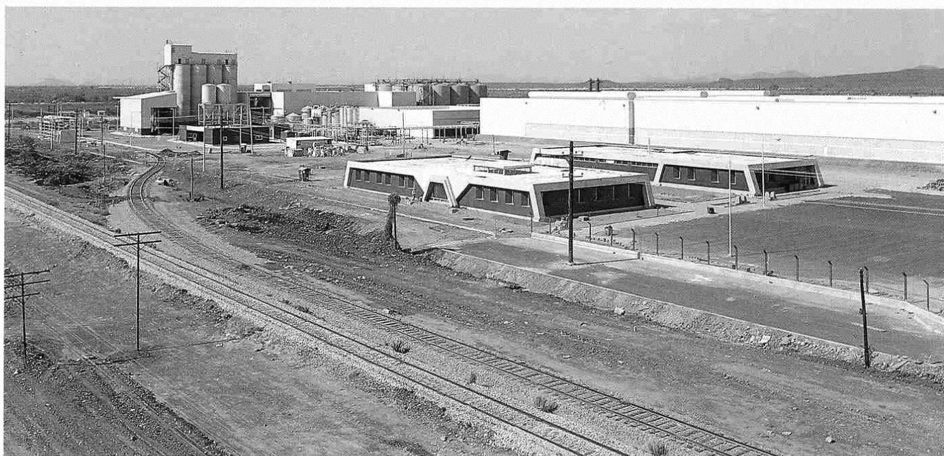
Vista general de la planta de la Cervecería Cuauhtémoc, con capacidad de 150,000 hectolitros mensuales, en Navojoa, Son.; abajo, tanque con capacidad de 500,000 barriles en la refinería Antonio Dovalí Jaime, en Salina Cruz, Oax.
