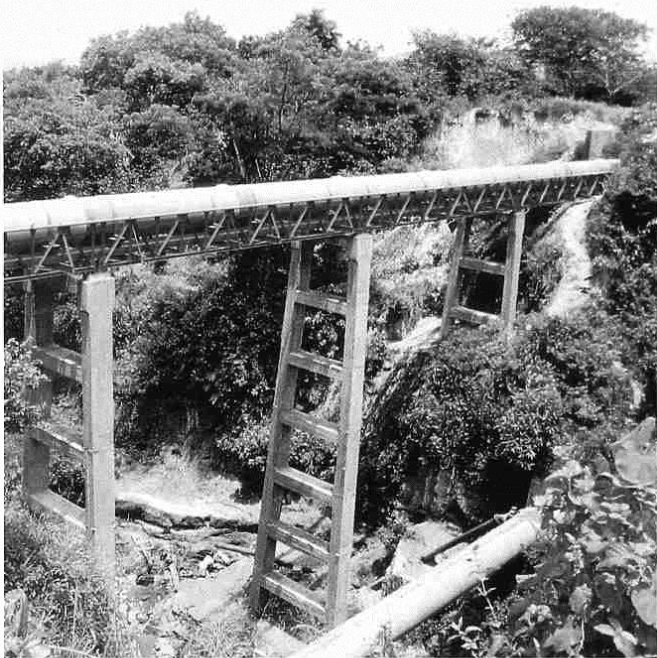
Estructura-puente para el cruce de una quebrada en el acueducto Río Lempa, en El Salvador.
